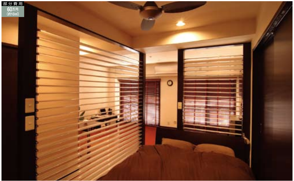
豊島区N氏邸 / LDKの開口部からの光を取り込めるように、寝室との間仕切りはアルミルーバーを採用。羽の向きは手動で変えることができ、明るさを自由に調節できる。木目とスチールの組み合わせで、寝室にふさわしい落ち着いた雰囲気を醸し出している
